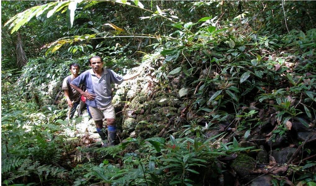
Turap dari tumpukan batu kali , pada bagian pondasi bekas bangunan balai adat di Dodo baha
